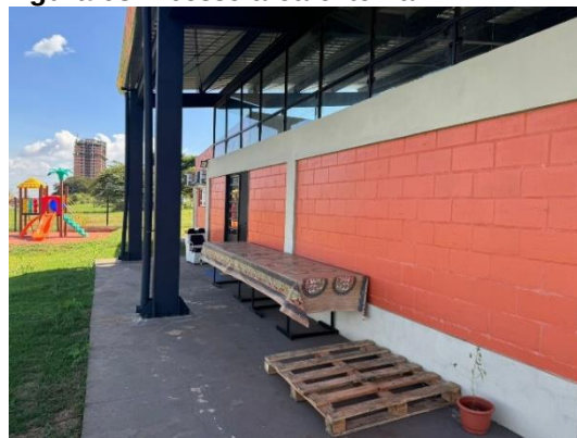
Figura 08. Acesso área externa
