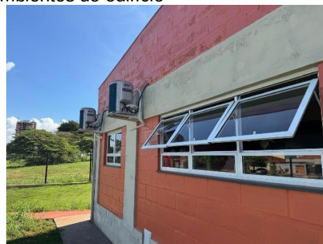
Figura 27. Esquadrias dos demais ambientes do edifício
