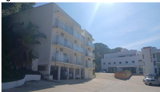
Figura 29. Prédio Flats - Hotel Beira Rio.
