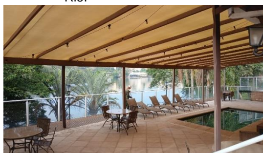
Figura 15. Área Externa Vista 01 - Hotel Beira Rio.
