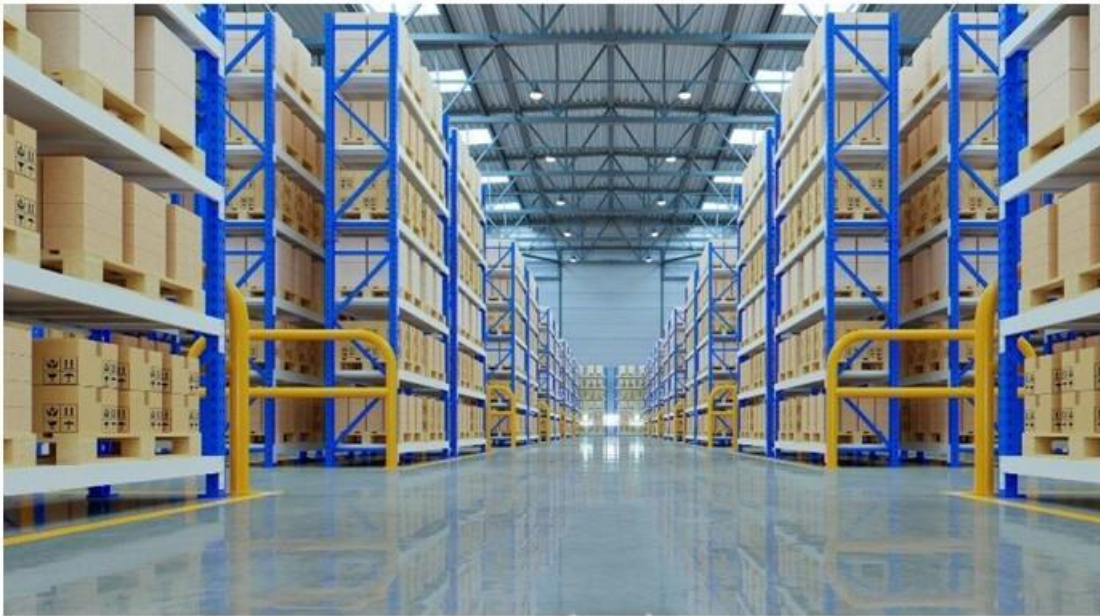
Figura 02. Layout em linha reta de Centro de Distribuição
