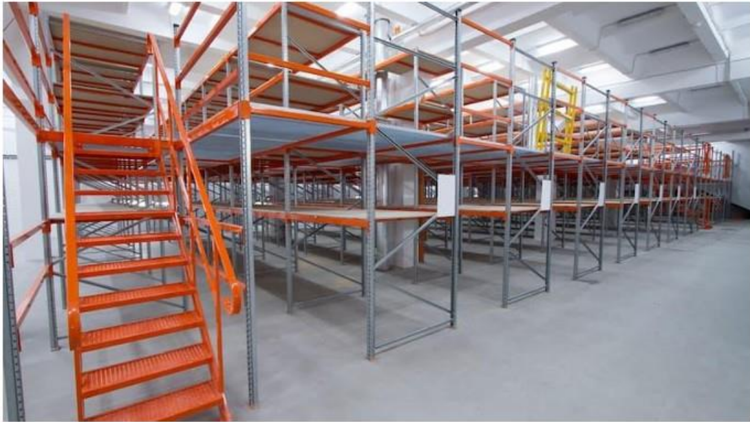
Figura 09. Sistema de armazenagem mezanino.
