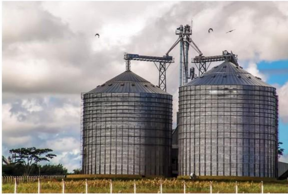
Figura 06. Sistema de armazenagem em silos.
