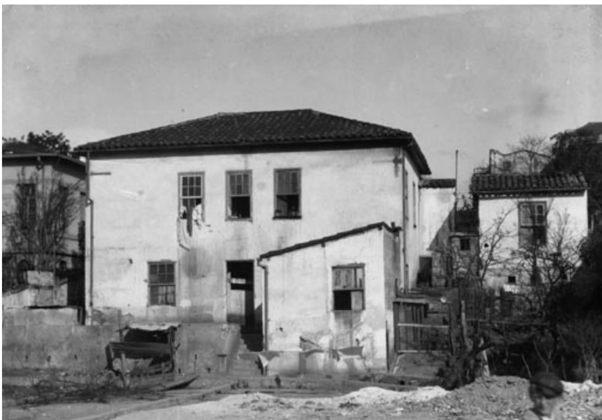
Figura 02: Cortiço localizado na Av. 9 de Julho
