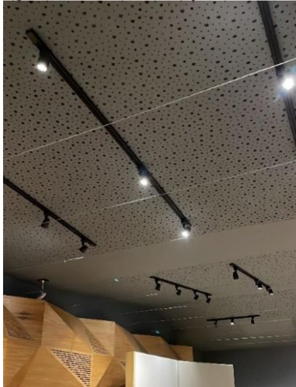
Figura 7 - Detalhe do forro de gesso – Estúdio A.
