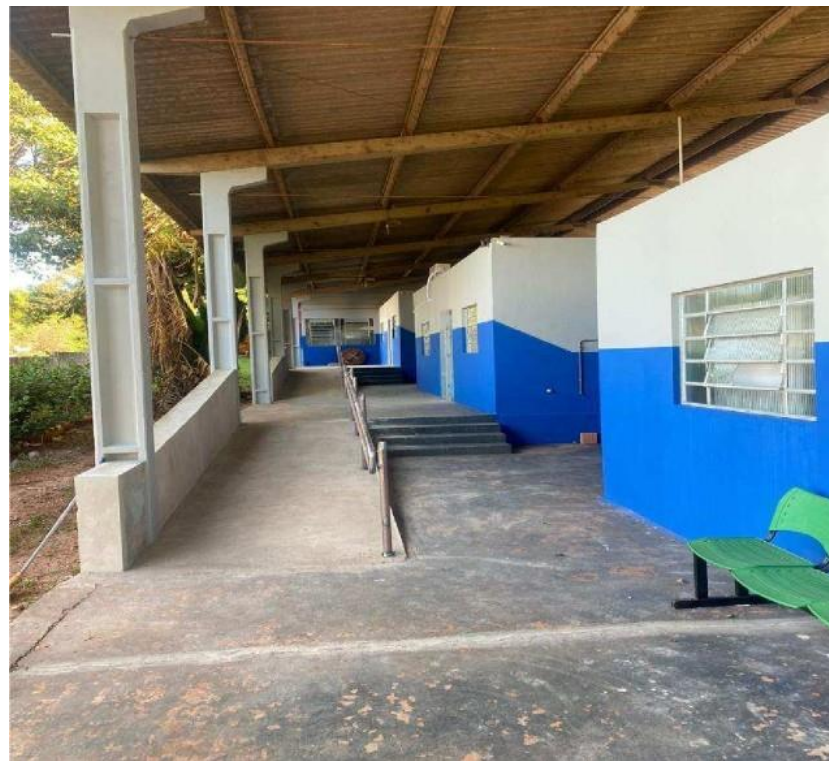
Figura 2 - Acessibilidade do prédio
