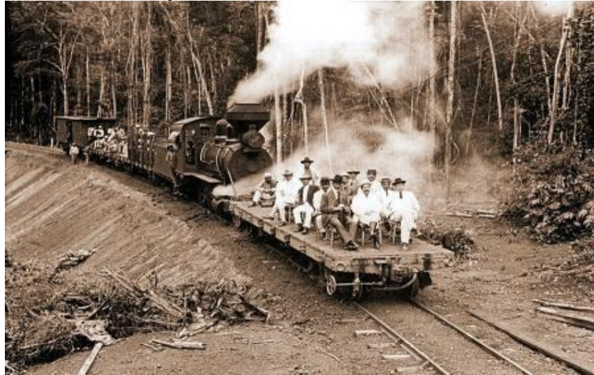
Imagem 03: Autoridades em um trem na Amazônia, na época da construção da ferrovia Madeira-Mamoré.
