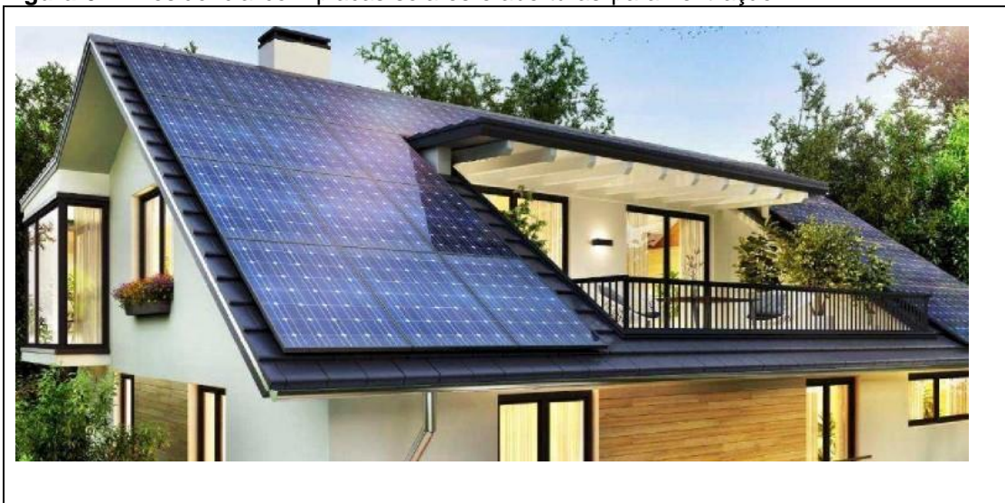
Figura 01 - Residência com placas solares e aberturas para ventilação.
