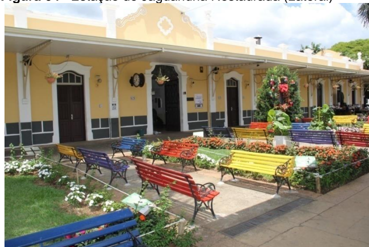
Figura 04 –Estação de Jaguariúna Restaurada (Lateral)
