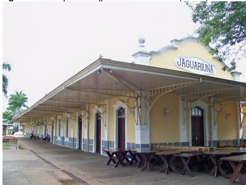
Figura 03 –Estação de Jaguariúna Restaurada (Frente)
