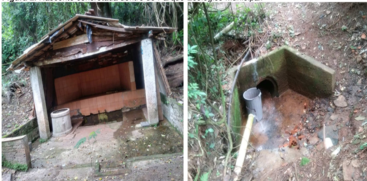
Figura 2. Nascente concretada dentro do Parque Ecológico Municipal.
