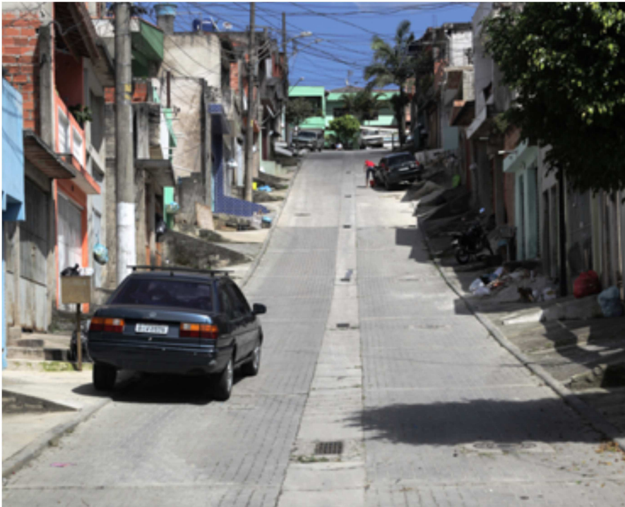
Figura 2- Ruas com piso intertravado no centro da via
