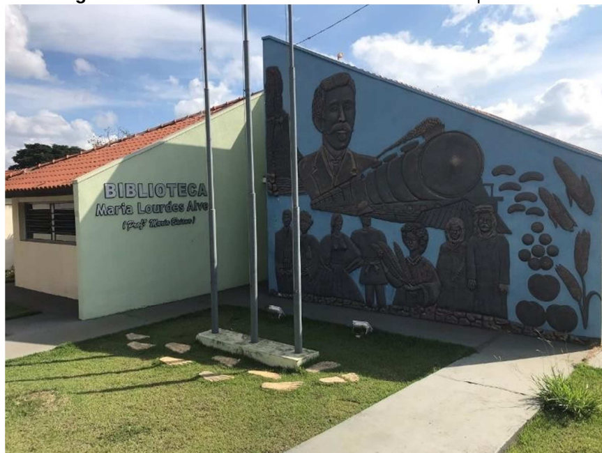
Figura 05 – Fachada contendo o único acesso ao prédio
