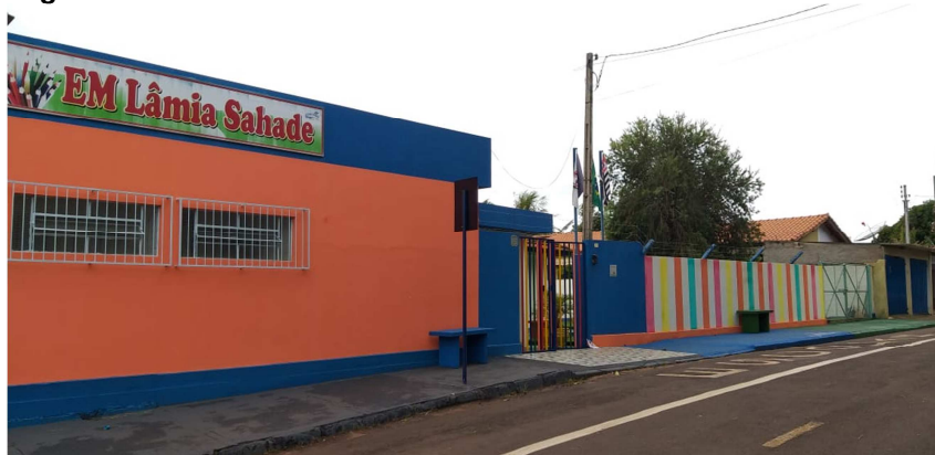
Figura 02. Foto entrada da Creche Lâmia Sahade.
