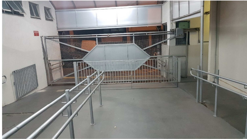
Figura 5: Rampa para acesso alternativo
