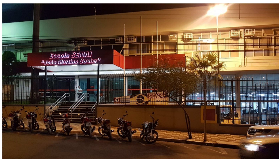
Figura 1 – fachada Senai Bauru.
