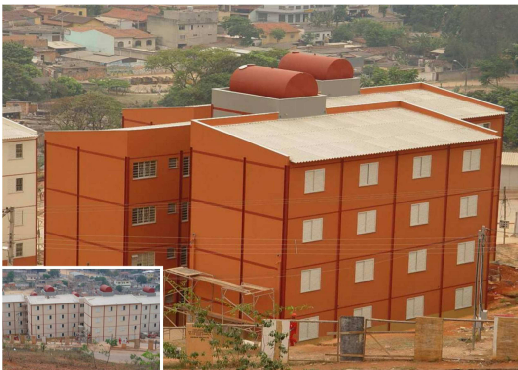
Figura 05 –H.I.S. em estrutura metálica no Brasil.
