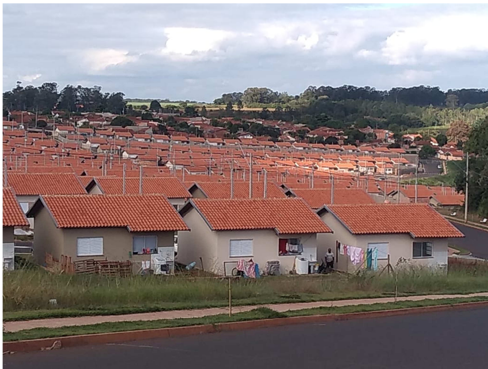
Figura 02 – Conjunto Habitacional ECO VILLE.
