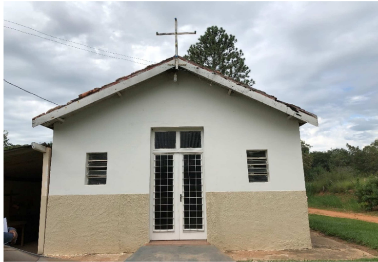
Figura 08 – Fachada da Capela.
