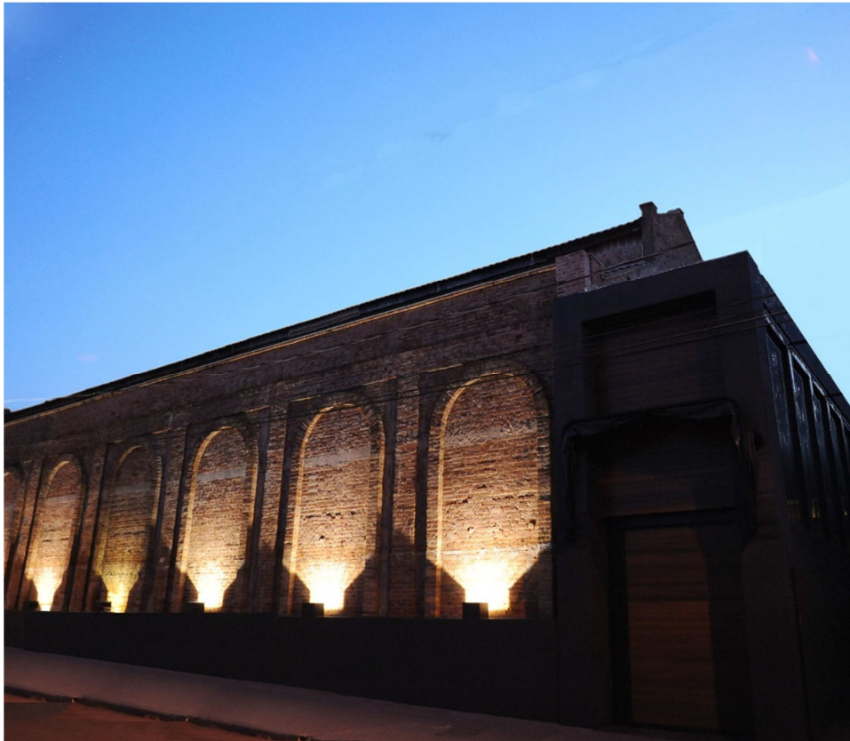
Figura 02. Fachada principal do Empório Guimarães.
