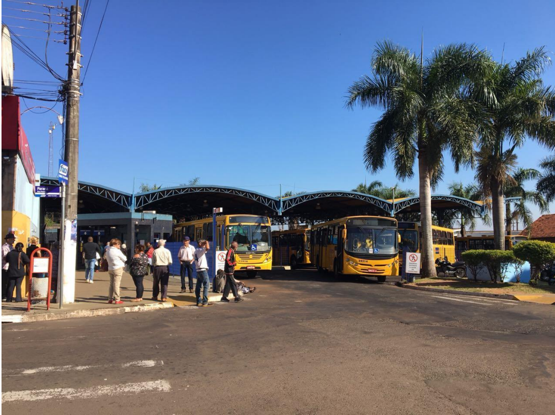
Figura 1 - Terminal Urbano de Integração de Passagens.
