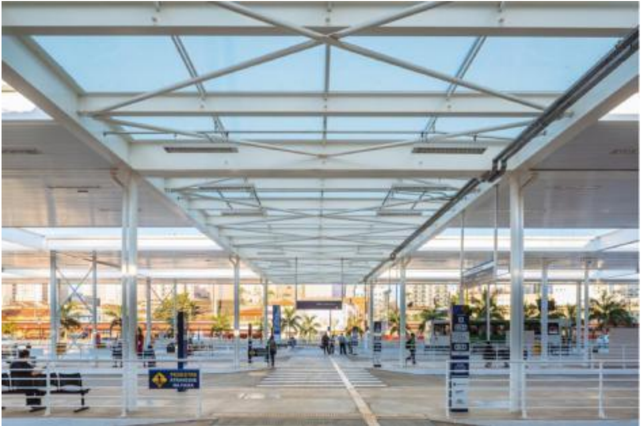
Figura 10 - Cobertura de vidro do Terminal.
