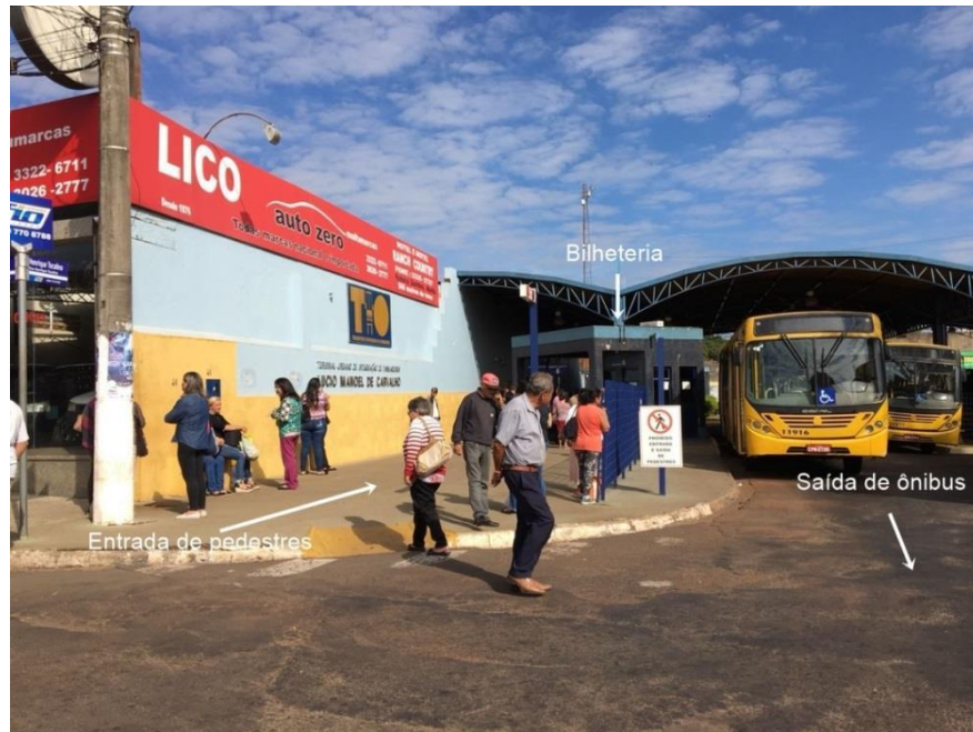
Figura 6 - Vista da entrada do Terminal Urbano.
