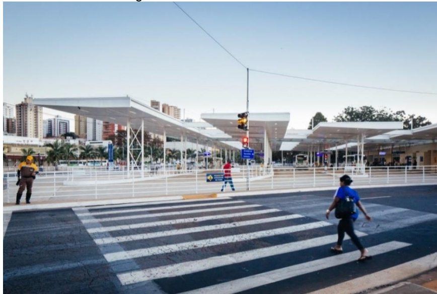
Figura 12 - Terminal visto da rua.
