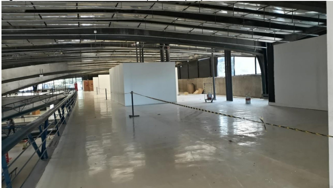
Figura 06: Pavimento 810 - corredor e espaço de exposição.
