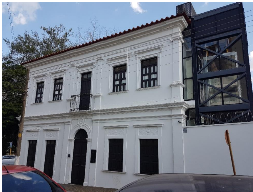
FIGURA 03 – VISTA LATERAL DO EDIFÍCIO
