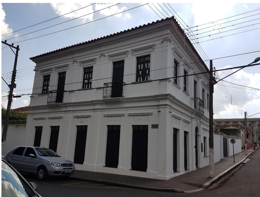
FIGURA 02 – VISTA EXTERNA DO EDIFÍCIO
