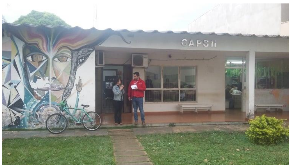
Figura 01. Fachada do CAPS II de Ourinhos-SP.
