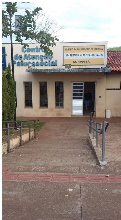
Figura 02. Fachada do CAPS III de Londrina-PR.
