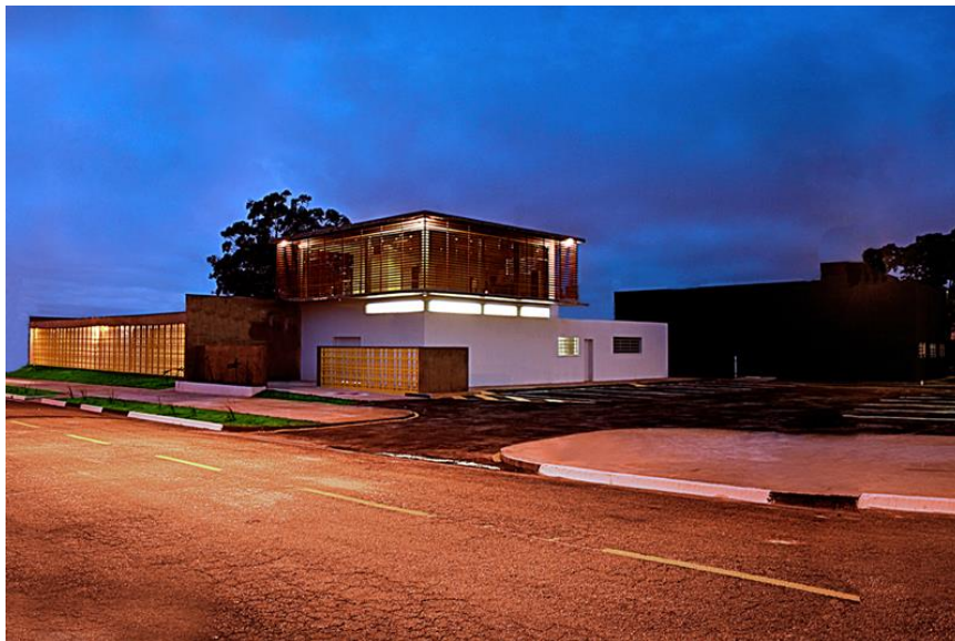
Figura 01. Fachadas do Ambulatório de Especialidades Médicas, Suzano, São Paulo.
