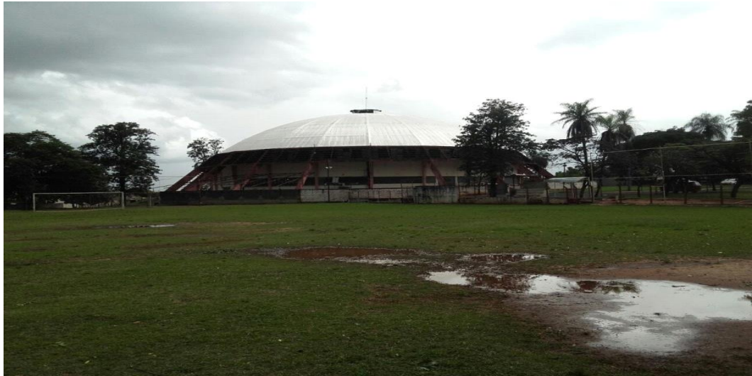
Imagem 04 –Estrutura Cobertura Externa – Ginásio Panela de Pressão.
