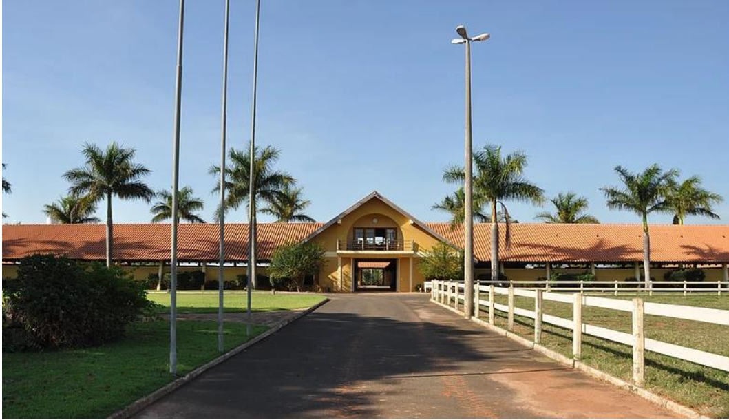
Figura 03 – Fachada Haras Zd
