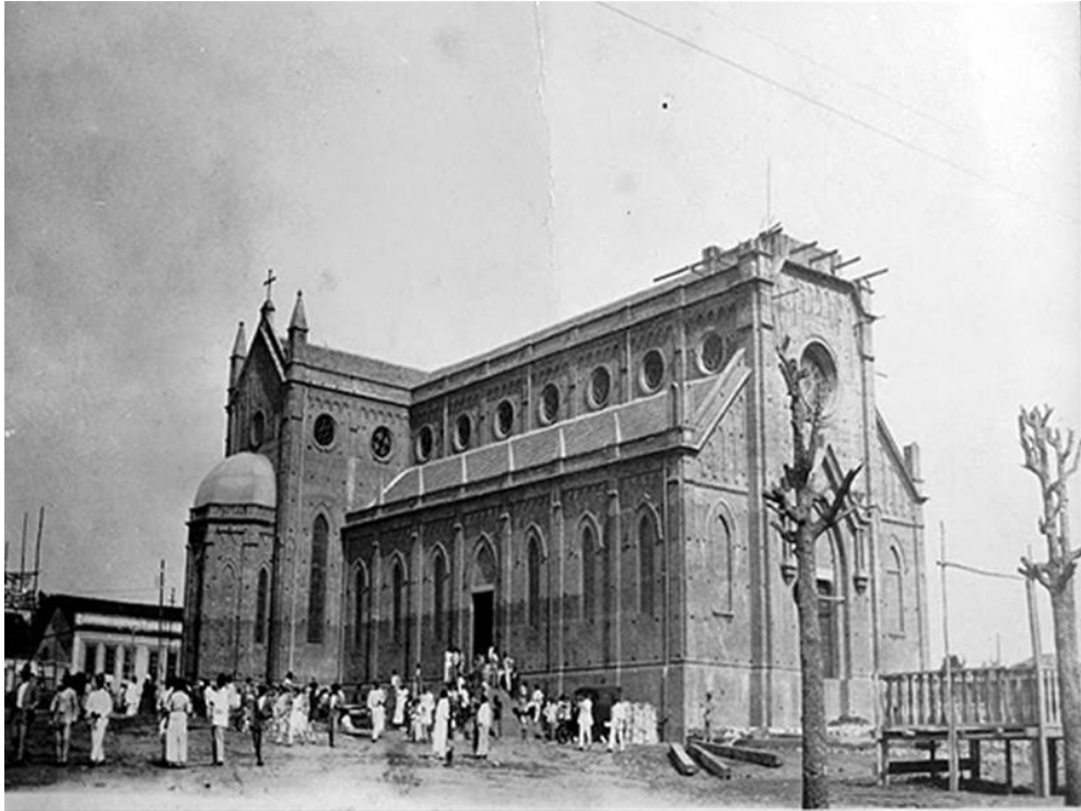
Figura 01. Imagem da Matriz em Construção no ano de 1931.
