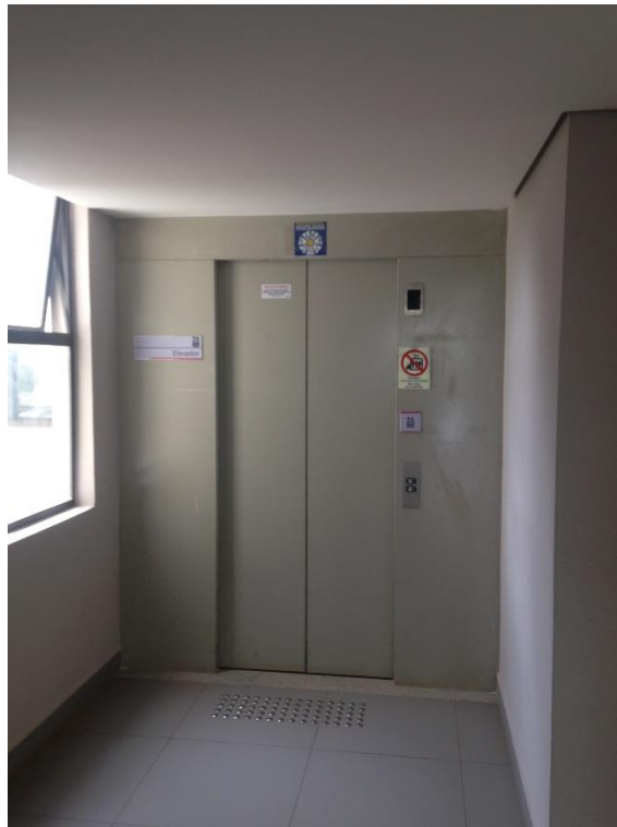
Figura 22: Elevador de Acesso
