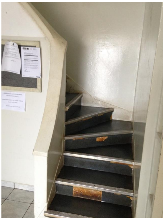
Figura 07: Escada de acesso ao pavimento superior
