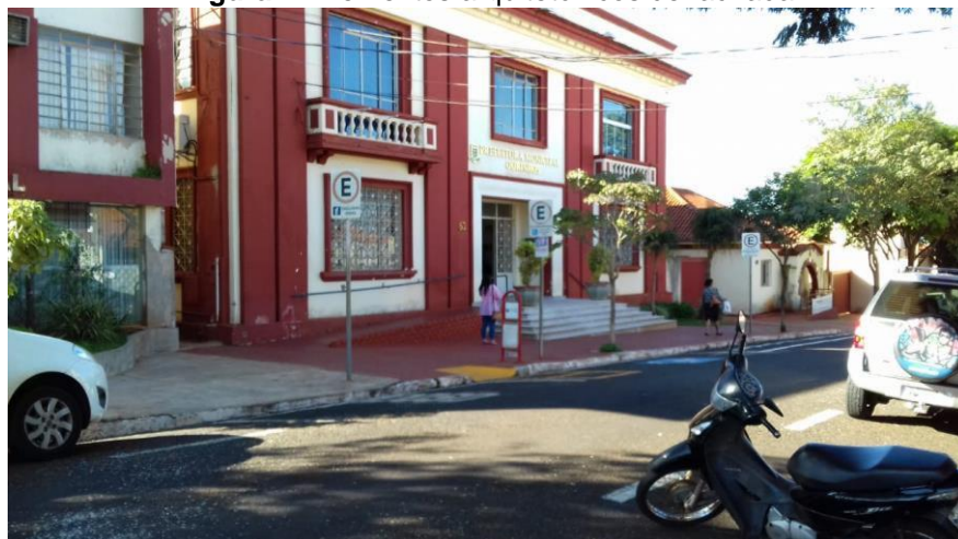
Figura 7: Elementos arquitetônicos de fachada
