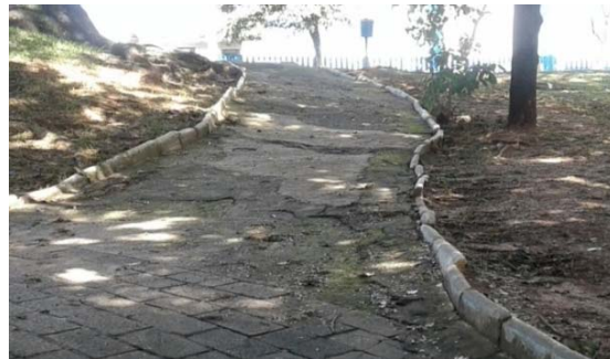
Figura 03. Rampa com piso irregular
