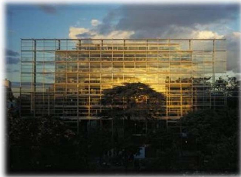
Figura 04: Fachada - Fundação Cartier (2013) – JEAN NOUVEL
