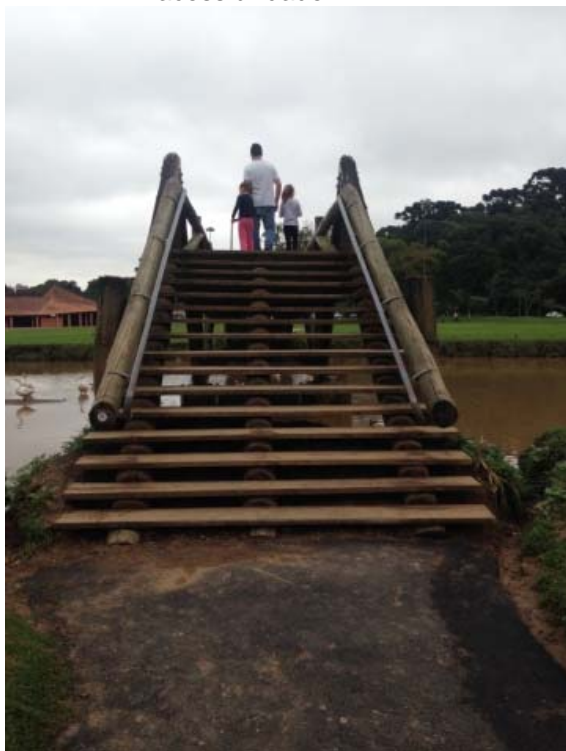
Figuras 06. Vista para a Ponte de Madeira sem acessibilidade
