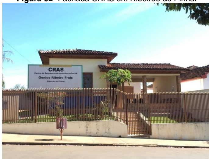
Figura 02- Fachada CRAS em Ribeirão do Pinhal
