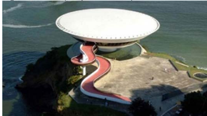
Figura 02. MAC (rampa de acesso).
