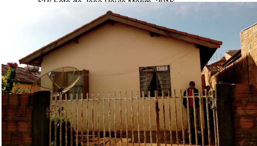
Figura 2. Fachada da residência do complexo habitacional de Sarutaiá-SP/ Foto de João Paulo Morim, 2016
