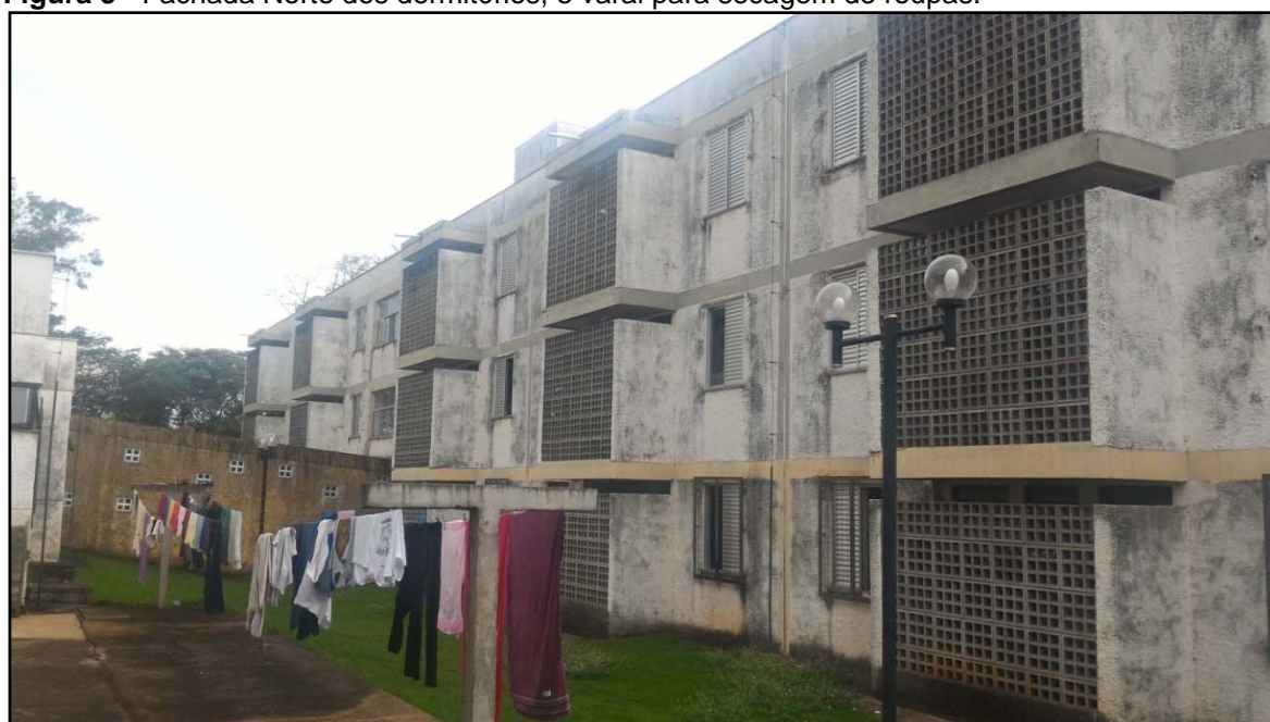
Figura 5 - Fachada Norte dos dormitórios, e varal para secagem de roupas.
