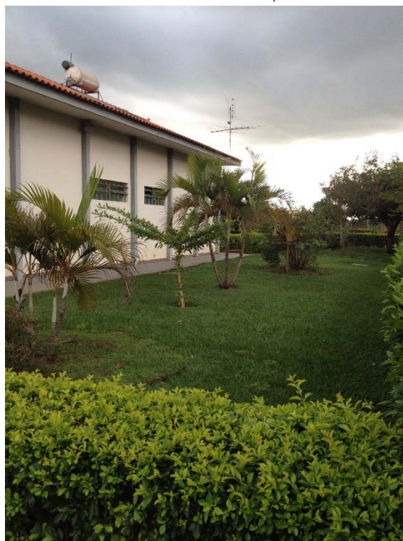
03. Fachada lateral da APAE Rural, Ourinhos – SP
