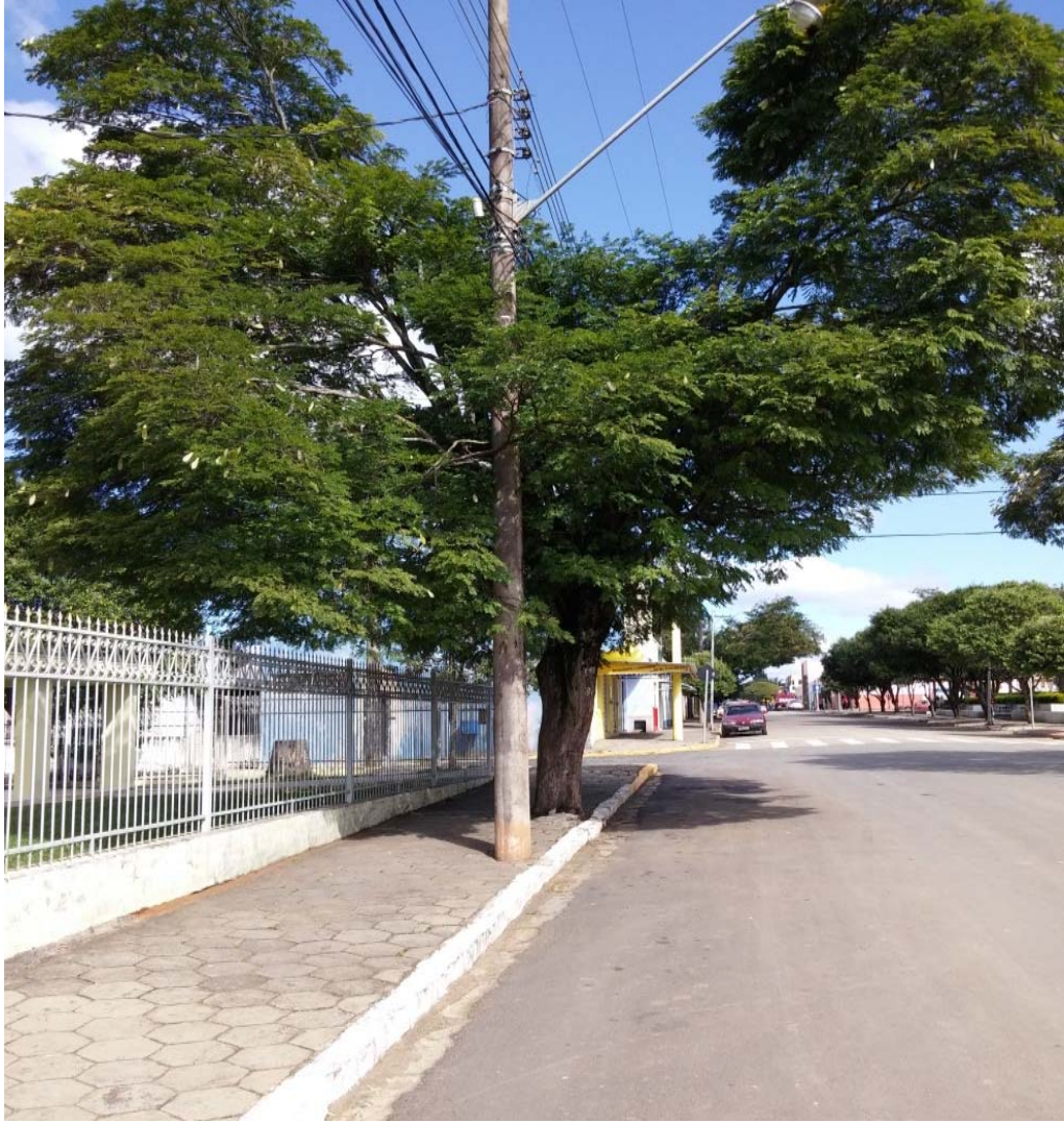
Figura 2. Caesalpinia peltophoroides (sibipiruna) em conflito com a rede elétrica.
