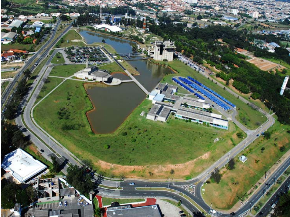
Figura 1. Vista Aérea do Paço Municipal de Sorocaba
