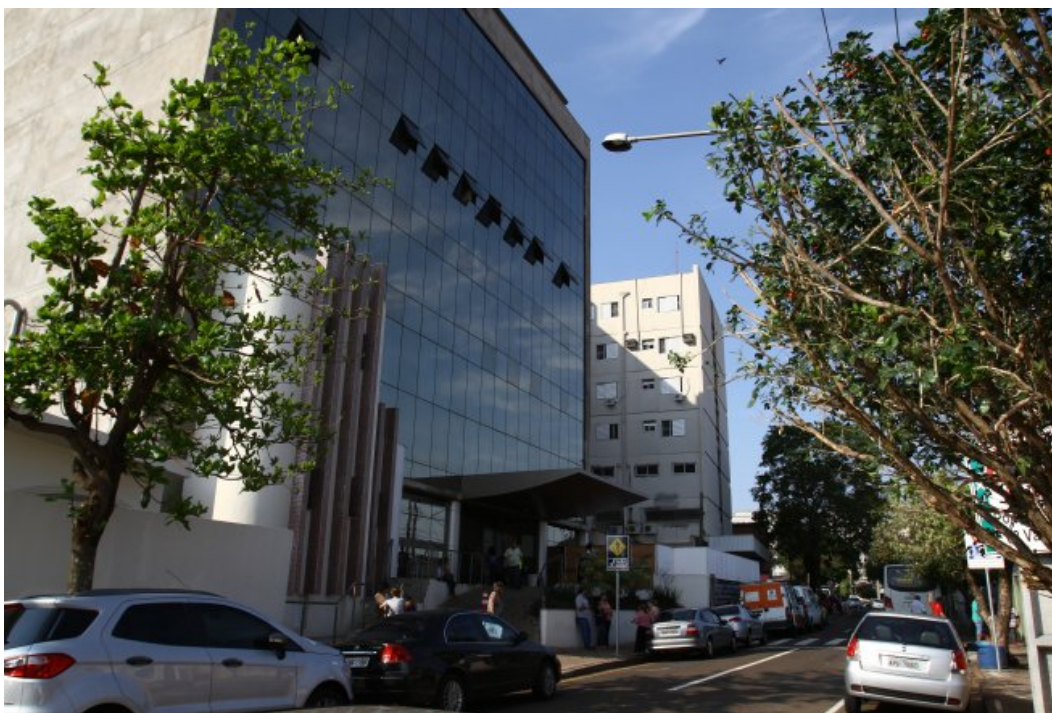
Figura 02. Fachada Hospital do Câncer de Londrina.
