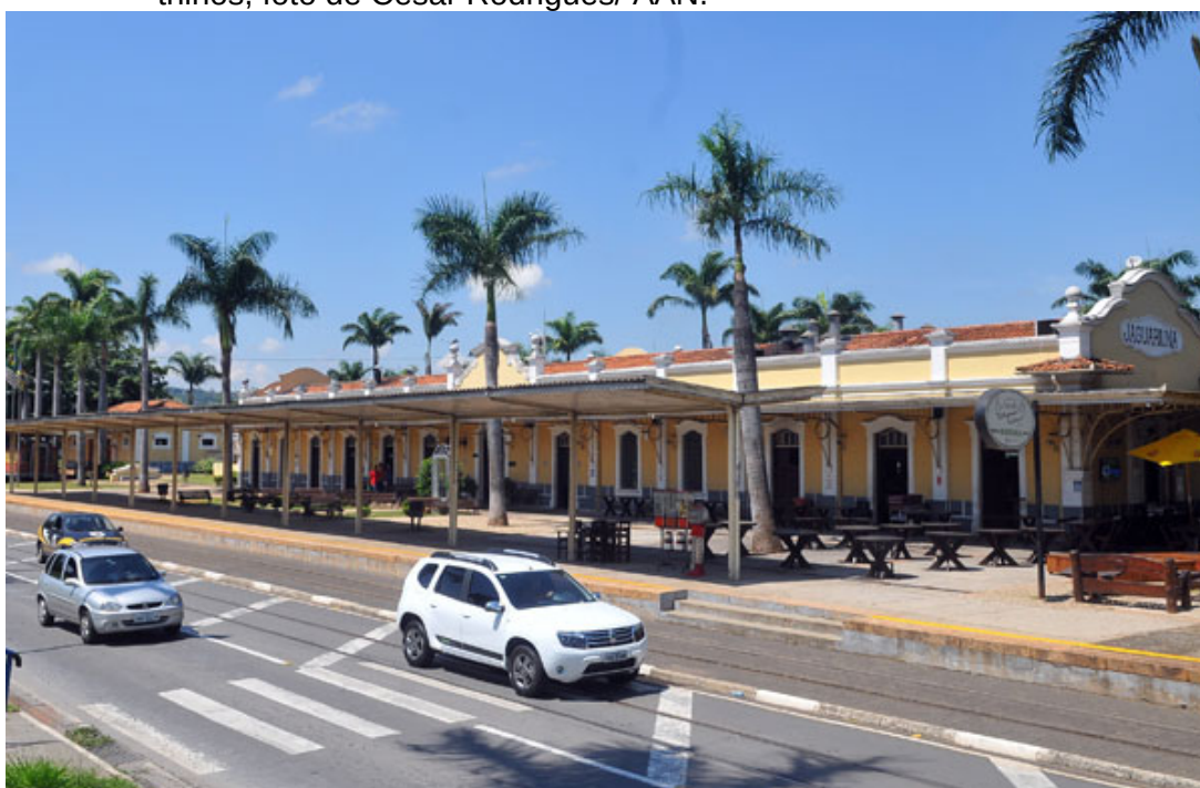
Figura 03. Estação Ferroviária de Jaguariúna no ano de 2014, fachada do lado dos trilhos, foto de Cesar Rodrigues/ AAN.
