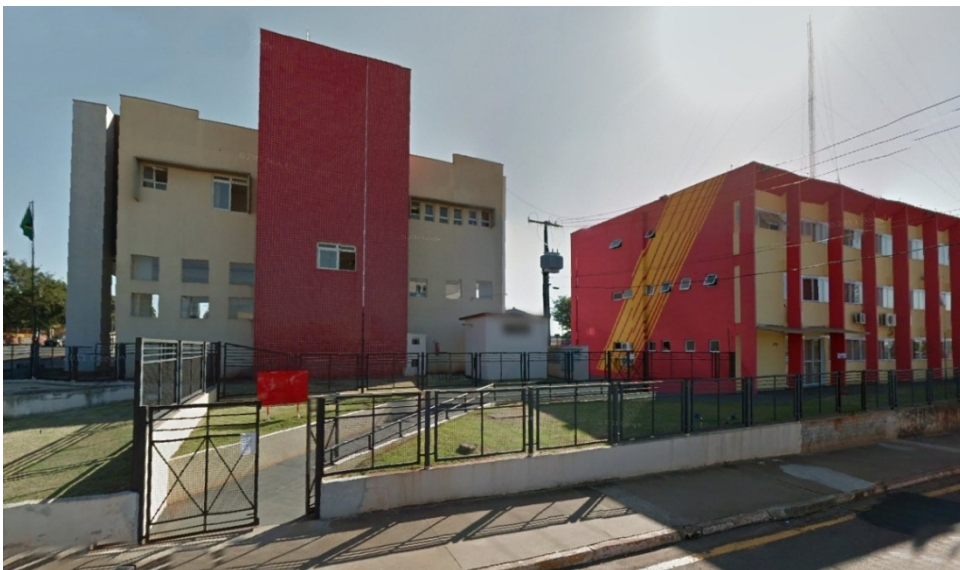
Figura 03. Entrada lateral Setor Administrativo.
