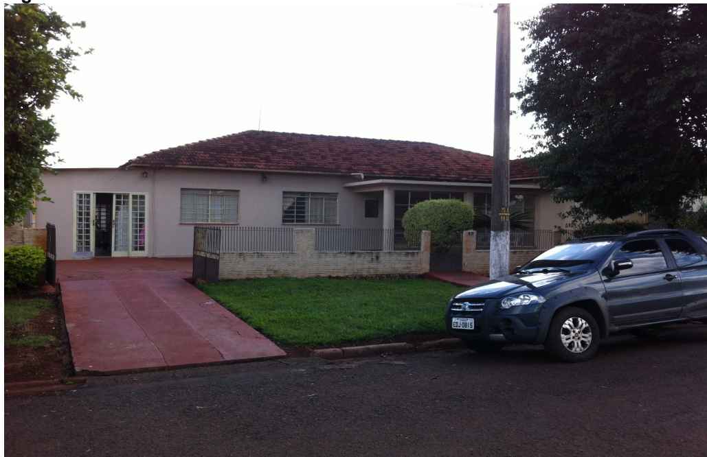
Figura 9: Fachada de Sede de Chavantes
