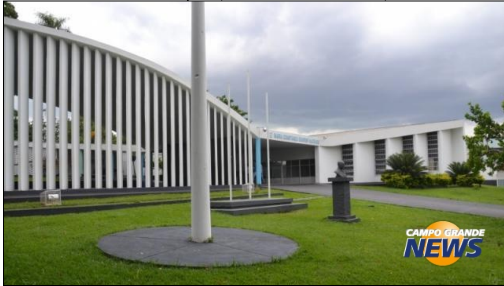
Figura 2. O projeto de Niemeyer optou por uma composição multi volumétrica, com diversas partes que, unidas por elementos de arquitetura – passarelas cobertas, circulações, pisos -, formam um todo arquitetônico”,
