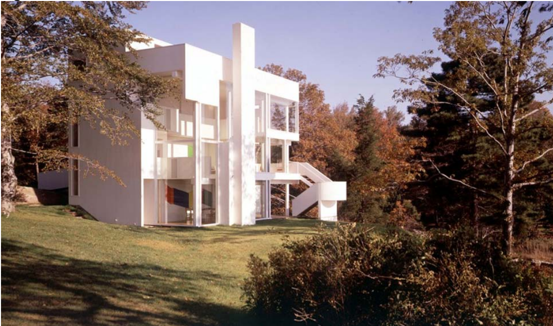
Figura 1. Vista Externa Casa Smith
