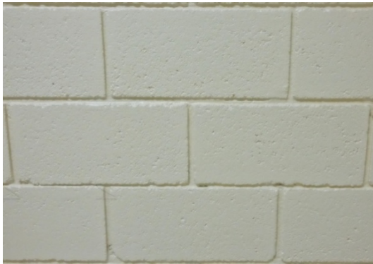
Figura 5. Parede do corredor bloco 3
