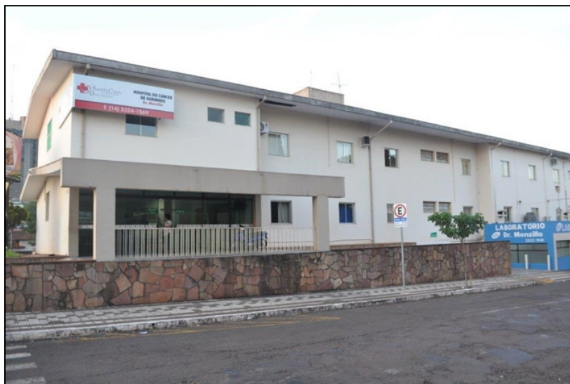
Figura 2. Foto da fachada lateral do Hospital do Câncer de Ourinhos
