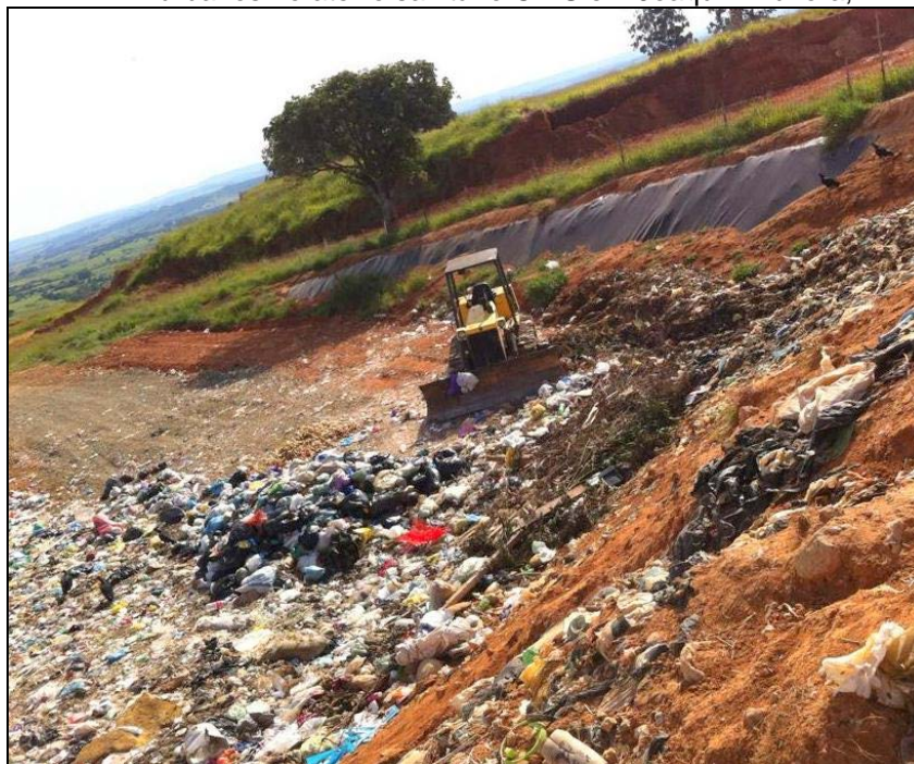
Figura 3. Vista de uma célula com deposição de resíduos sólidos urbanos no aterro sanitário CIAS em Joaquim Távora, PR.
