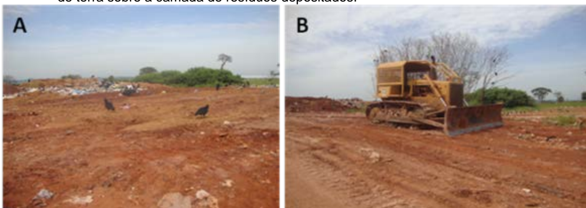
Figura 3. Aterro sanitário de Santo Antonio da Platina. A: lixo depositado para posterior compactação e cobertura com terra; B: trator de esteira para compactação de cobertura de terra sobre a camada de resíduos depositados.
