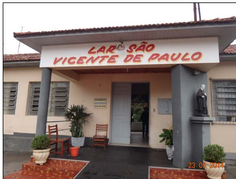
Figura 05. Fachada do edifício Lar São Vicente de Paulo
