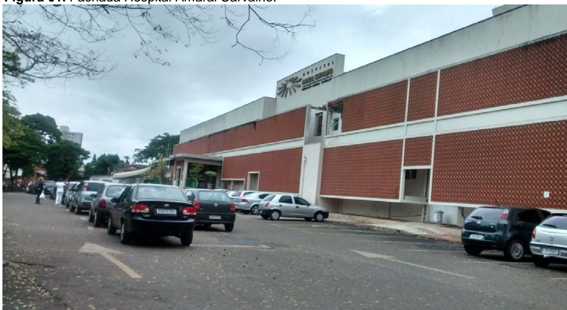
Figura 01. Fachada Hospital Amaral Carvalho.
