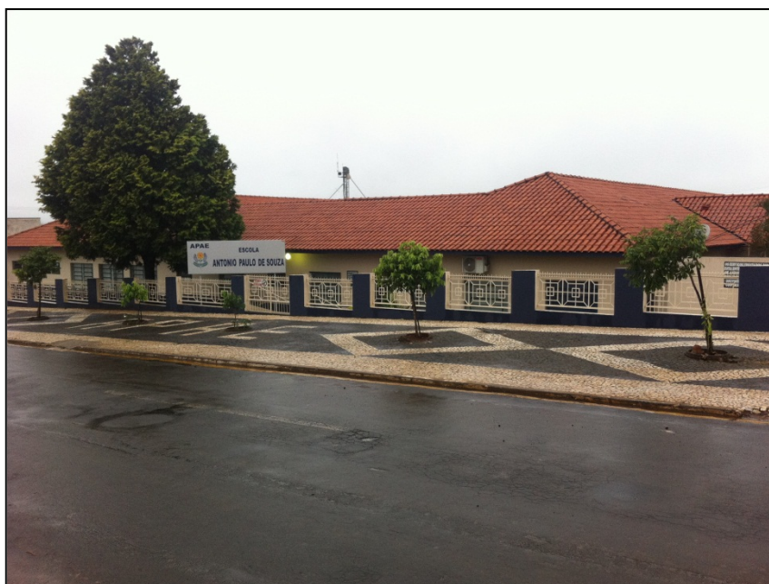
Figura 1. Fachada da Escola Antônio Paulo de Souza / APAE de Siqueira Campos. Fonte: Freitas, Gustavo Vieira.
