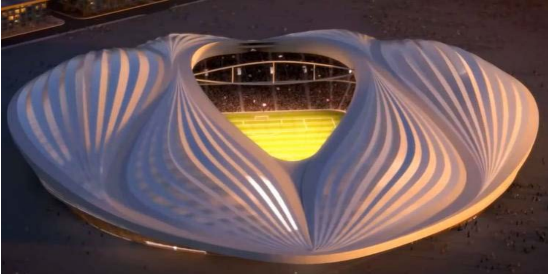
Figura 01. Estádio Mundial Qatar – Vista aérea.
